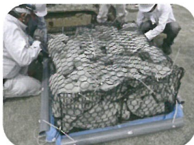
石倉カゴ増殖礁(下部に効果検証調査のための生け簾網が取り付けられている)
