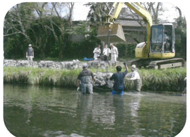
石倉カゴ増殖礁の設置作業(武儀川では28年9月に実施)
